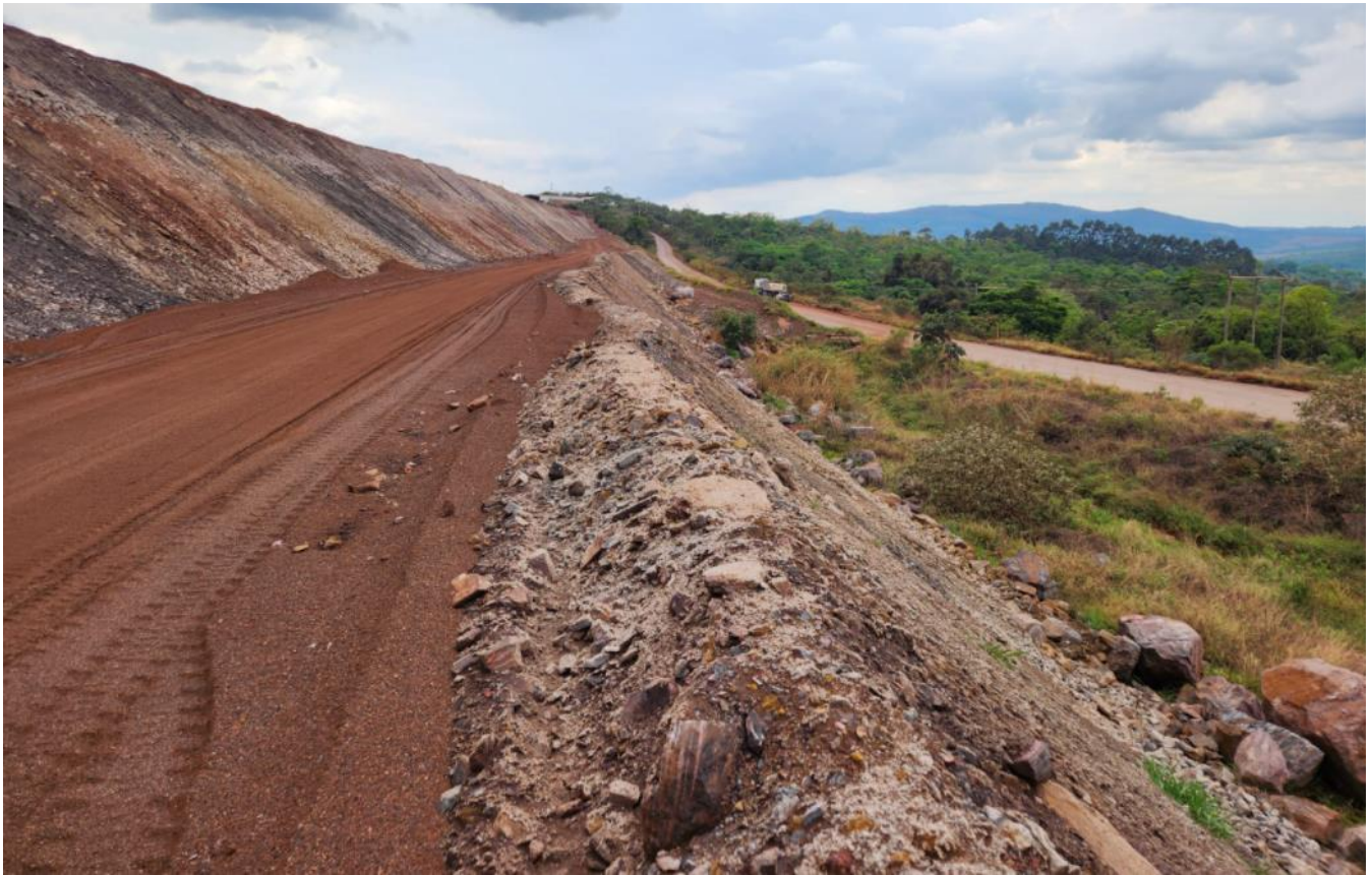
Talude da obra de reforço. Atividade já concluída.
