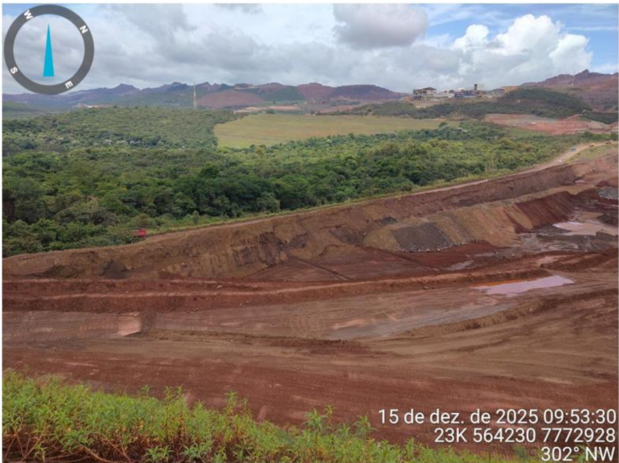
Figura 6.1: Visão da região do reservatório e do reforço de itabirito a partir da ombreira esquerda. Fonte: SAFF-MIN002-RT-004-R1 (SAFF, 2025).
