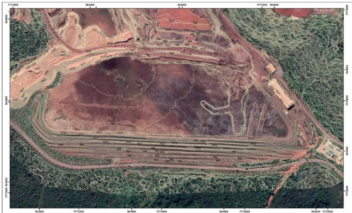
Figura 6.5: Imagem de satélite da Barragem B1B3 em 2019. Fonte: 002-2025-10-0003 (Geomil, 2025).
