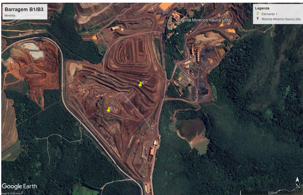
Figura 5.1: Localização da Barragem em relação à Unidade de Itatiaiuçu. Fonte: Google Earth, 28/03/25).
