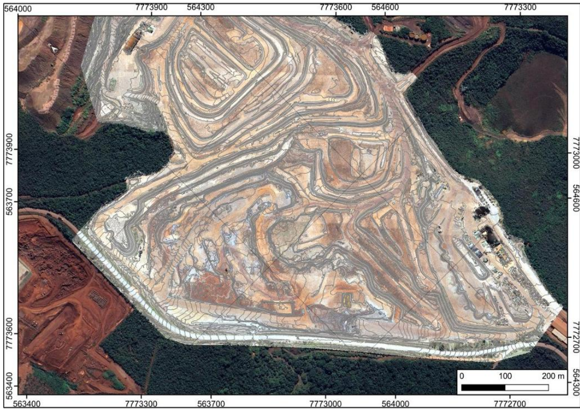
Figura 6.6: Imagem de satélite da Barragem B1B3 em 2025. Fonte: 002-2025-10-0003 (Geomil, 2025).
