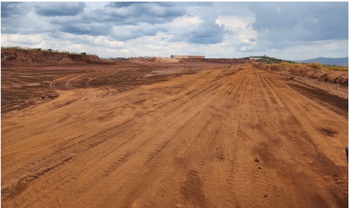
Superfície superior da barragem, praticamente nivelada na cota El. 1000 m.
