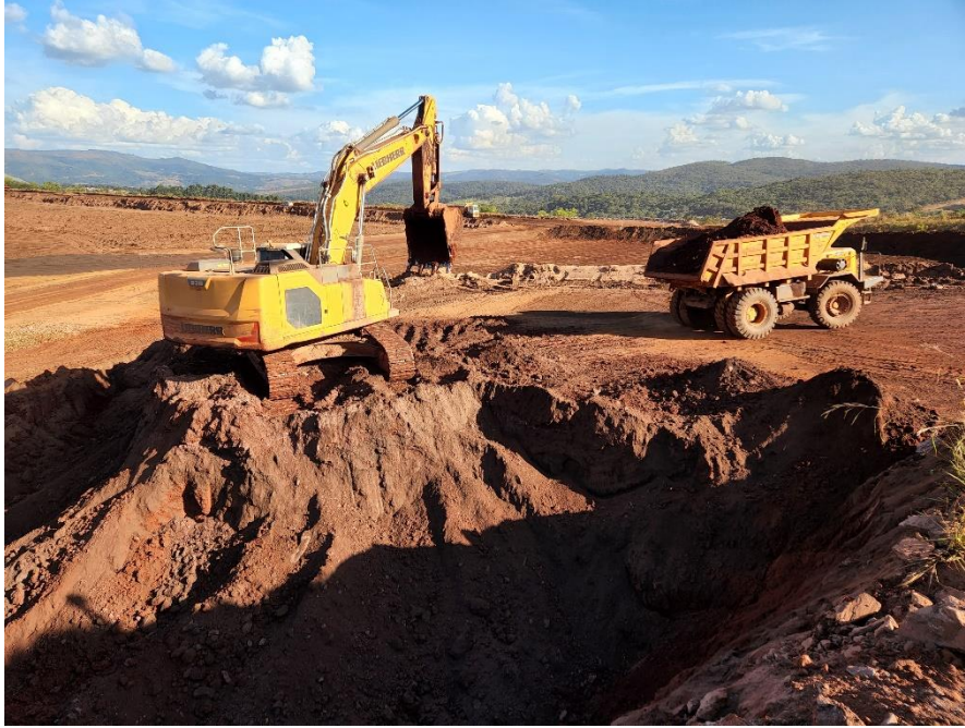
Escavação realizada por conjuntos escavadeiras e caminhões basculantes.
